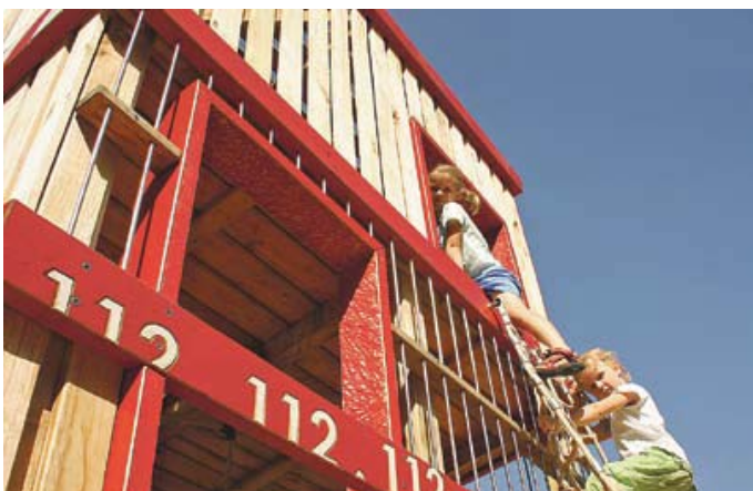
Der 4 m hohe Rettungsturm; Die quaderförmige Grundform wird durch die schräge Anordnung der inneren vier Spielebenen unterbrochen.
